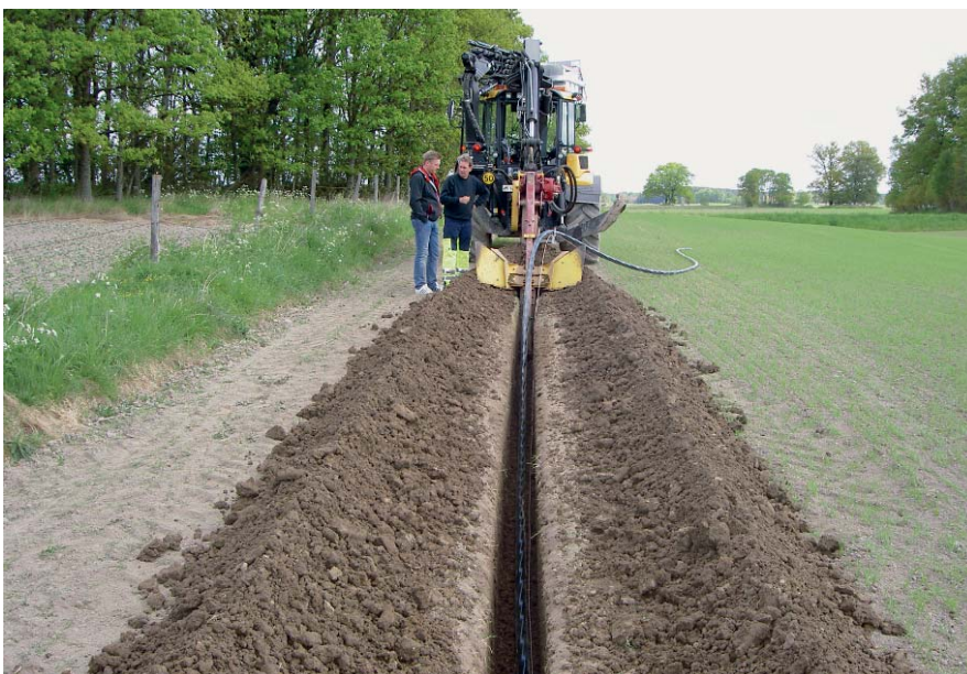
Provkörning av kedjegrävare vid kabelförläggning
